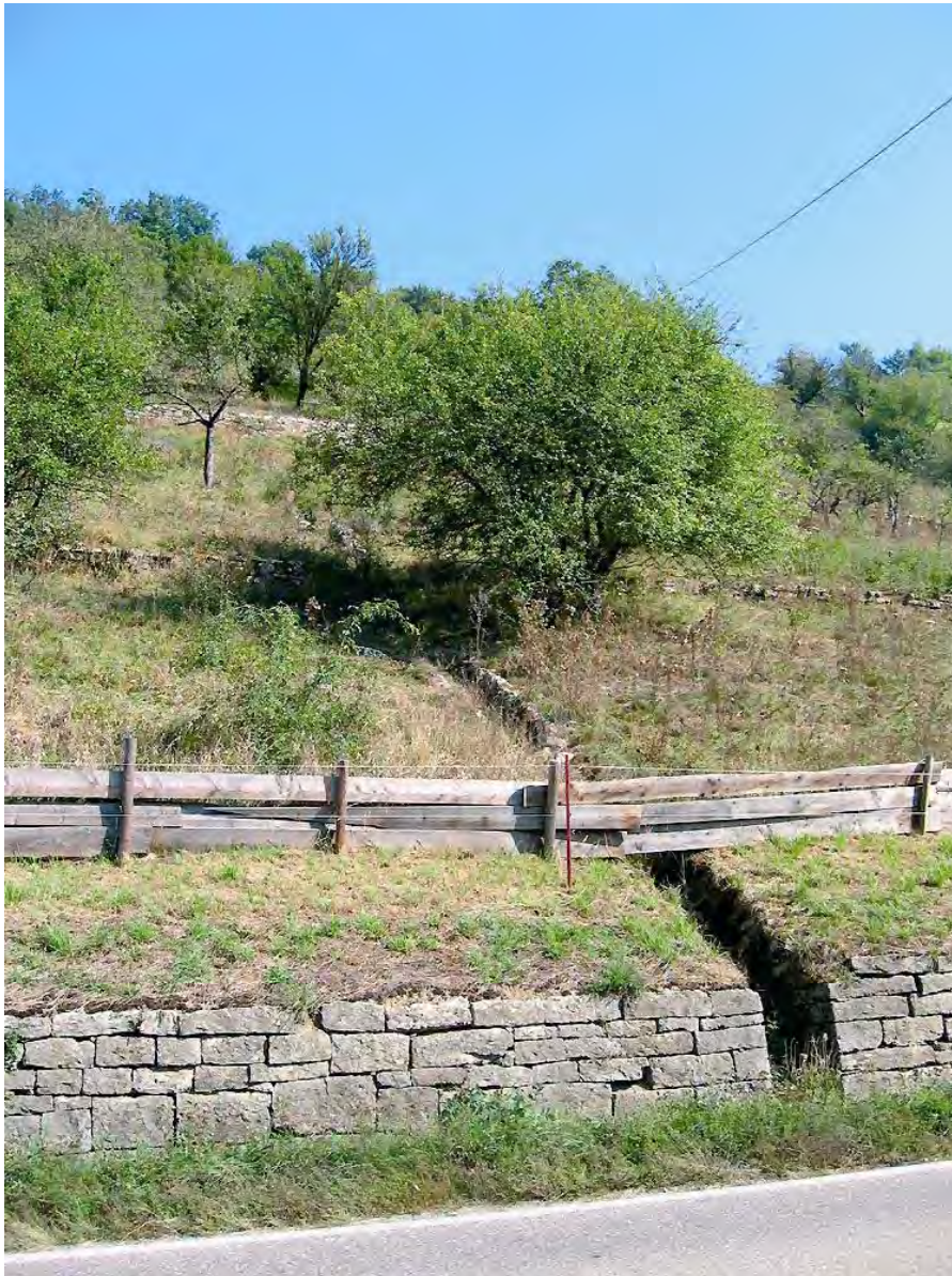
Photo 6: Steinschlagschutz der Straße (bb 2005)
